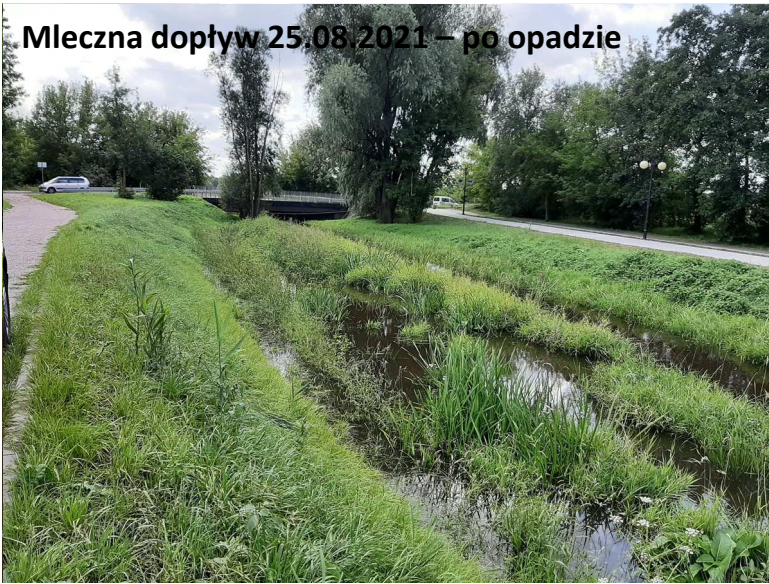
Zbiorniki kolmatacyjne 1 - z wysokim dnem, kolmatacyjnymi i niskim dnem - dla łatwego usuwania osadów przez wody
